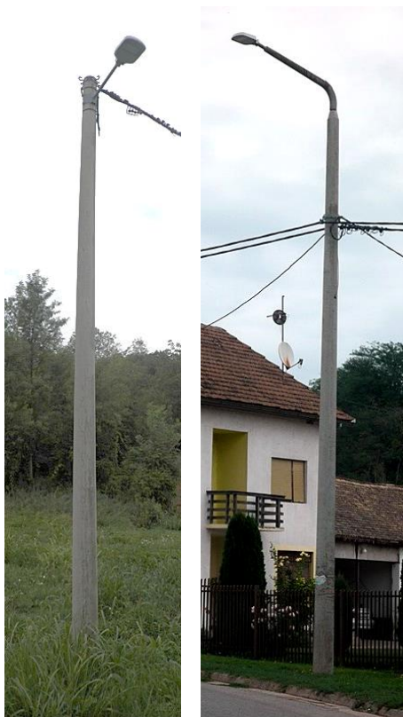
Slika 16. Armirano betonski stup visine 8m i 9m
