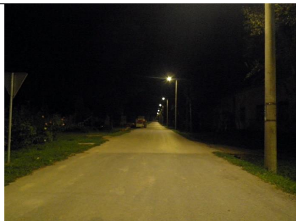
Prikaz rasvjetljenosti iste klase rasvjete sa pravilno postavljenim rasvjetnim tijelima – primjer dobre prakse
