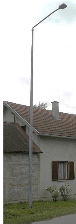
Slika 17. Metalni stup visine 10m
