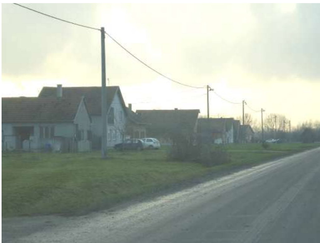
Slika 13. Prevelika udaljenost rasvjetnih stupova od ceste
