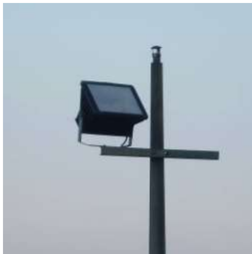
Slika 8. Reflektor LRV 12 400W HQI
