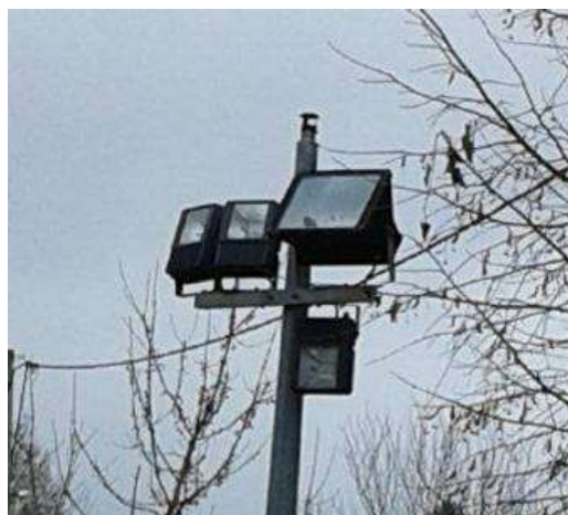
Slika 12. Reflektori LVR 12 400W HQI i LVR 09 150W HQI
