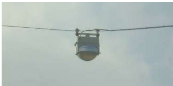
Slika 3. Gamalux LVC-06 V 150W NAV-E
