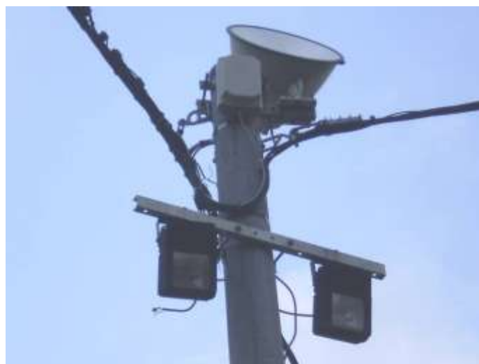
Slika 2. Reflektori LVR-09 150W HQI i LVR 507 250W HQI
