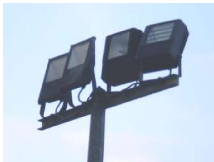
Slika 6. Reflektori LVR 09 150W HQI i Kanlux Fort 150W HQI
